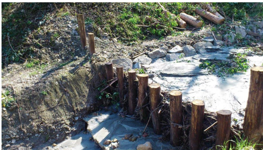
Figura 10 – La nuova briglia selettiva realizzata sul rio Bianello a marzo 2015. Si nota l'abbondante accumulo di detriti nella parte retrostante.
