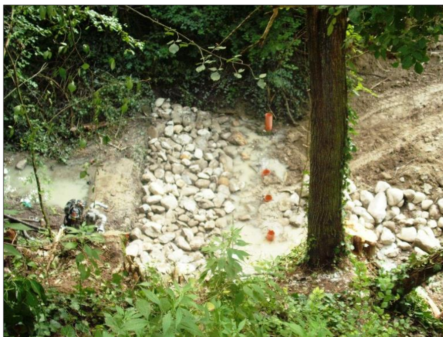
Figura 23 – Una fase della costruzione della rampa di risalita sul Rio Bertolini.
