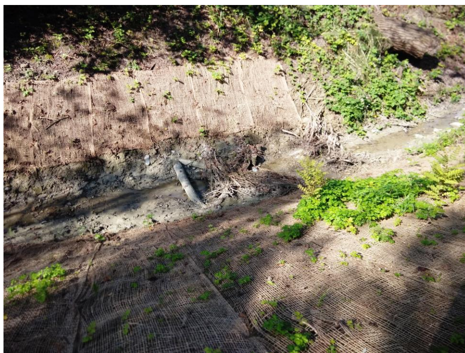
Figura 27 – Il salto di fondo naturaliforme con radici esposte nell'alveo del Rio Bottazzo al termine della sua realizzazione.
