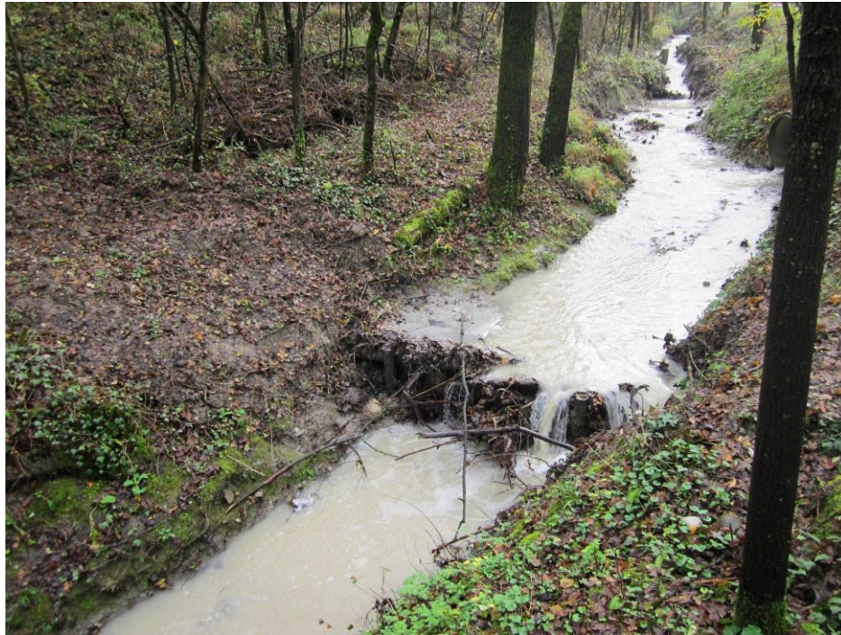
Figura 28 – Il salto di fondo naturaliforme durante le piogge fine ottobre 2014. Notare l'accumulo di materiale e l'invaso delle acque sul lato di monte in corrispondenza di una piccola golenia.
