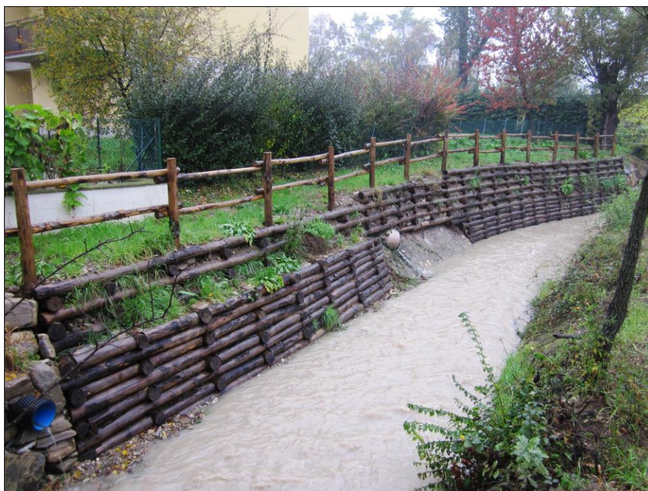
Figura 16 – La palificata realizzata sul Rio Lavezza durante le piogge di fine ottobre 2014.
