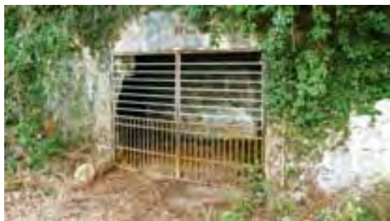
Ingresso di uno degli spazi di cava dopo la realizzazione degli interventi.
