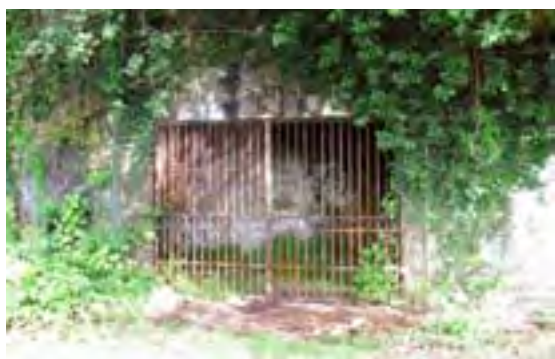
Ingresso di alcuni degli spazi di cava prima degli interventi.
