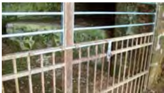
Dettaglio della chiusura di uno dei cancelli.
