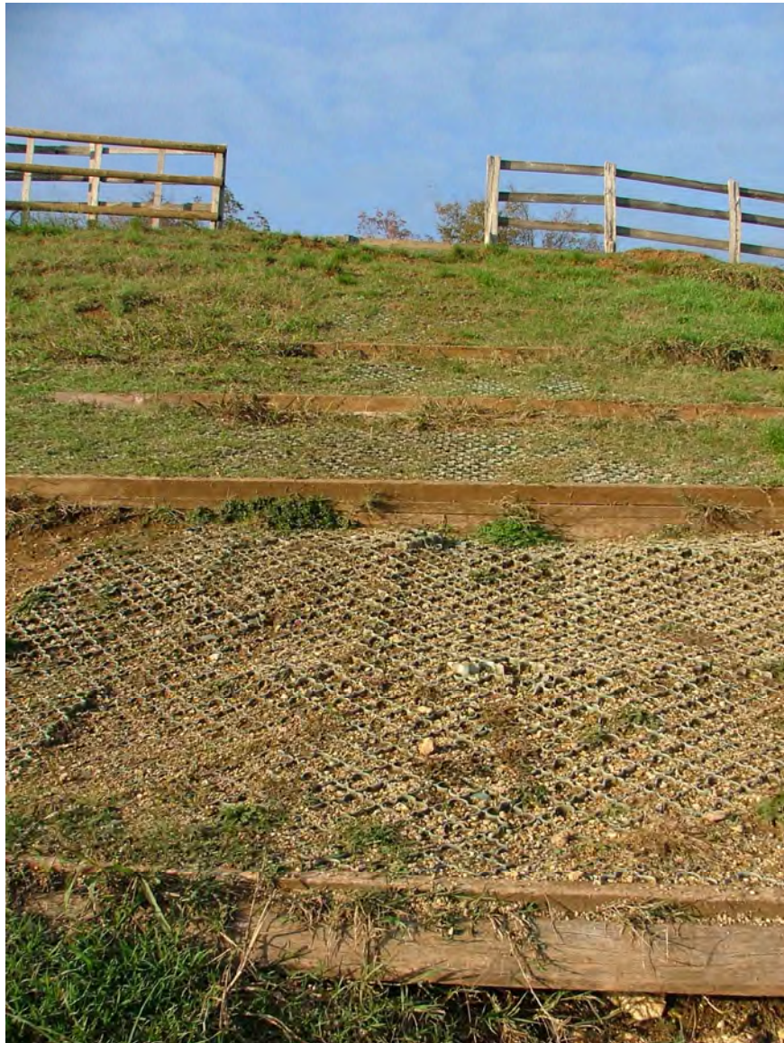
Foto 1 Rete metallica e gradini in legno nel settore centrale dell'area a valle della strada
