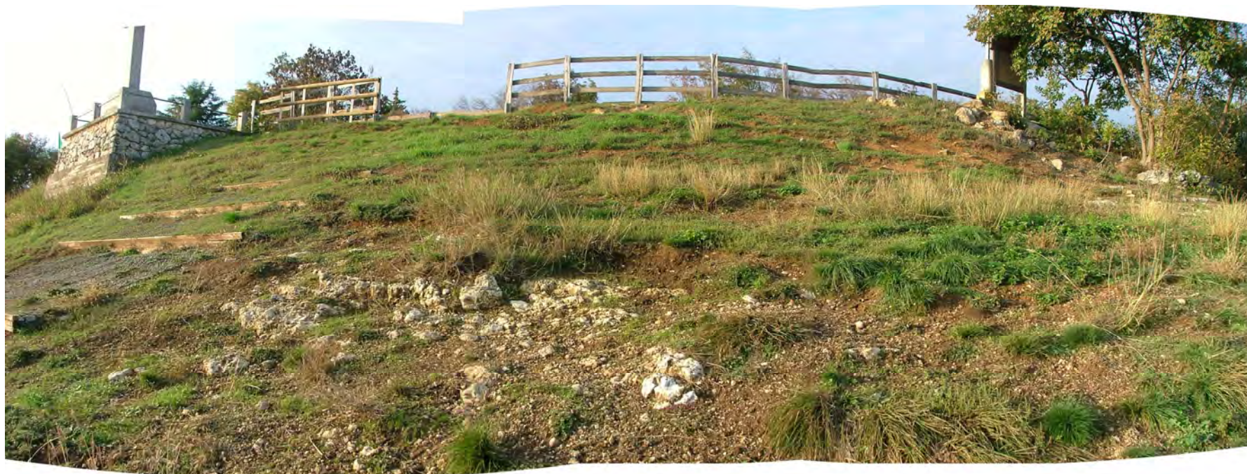
Foto 4. Evidenze di erosione superficiale nel settore est dell'area a valle della strada
