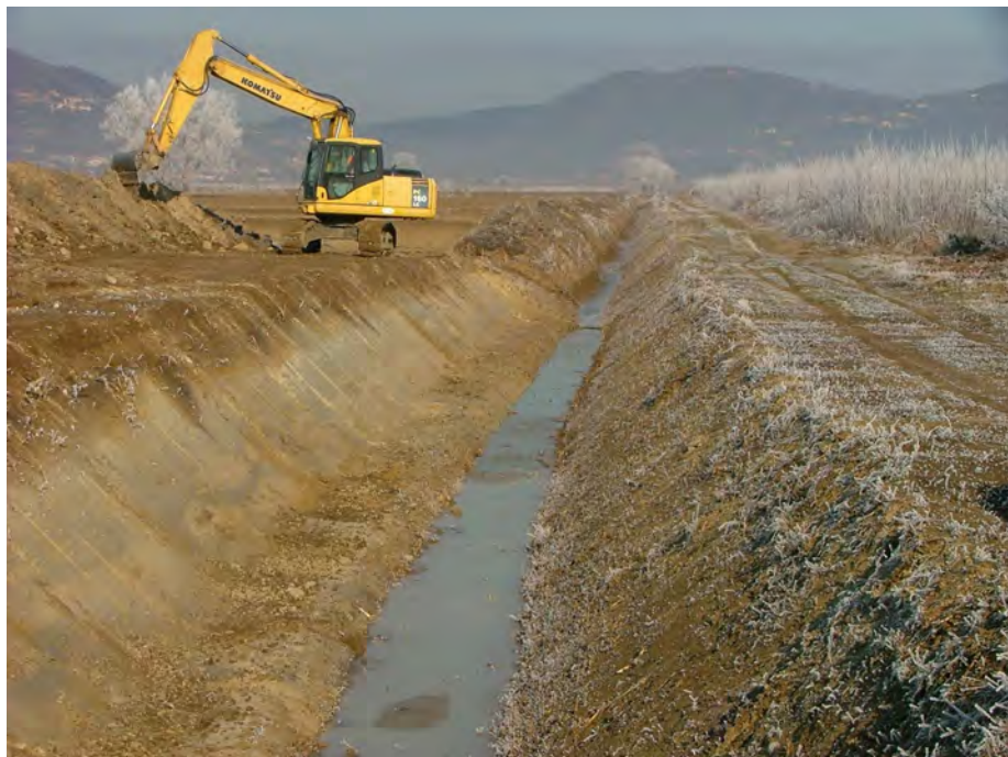
Figura 5-3. Lavori di risezionatura della Fossa di Mezzo (gen 2012)
