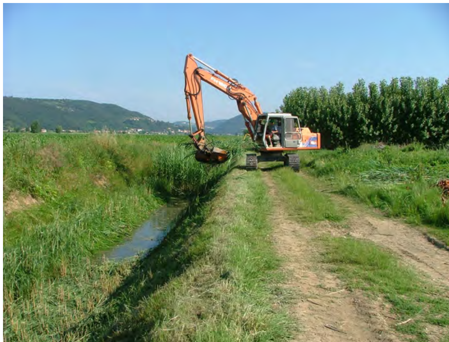
Figura 5-15. Manutenzione con benna falciante (giugno 2013)
