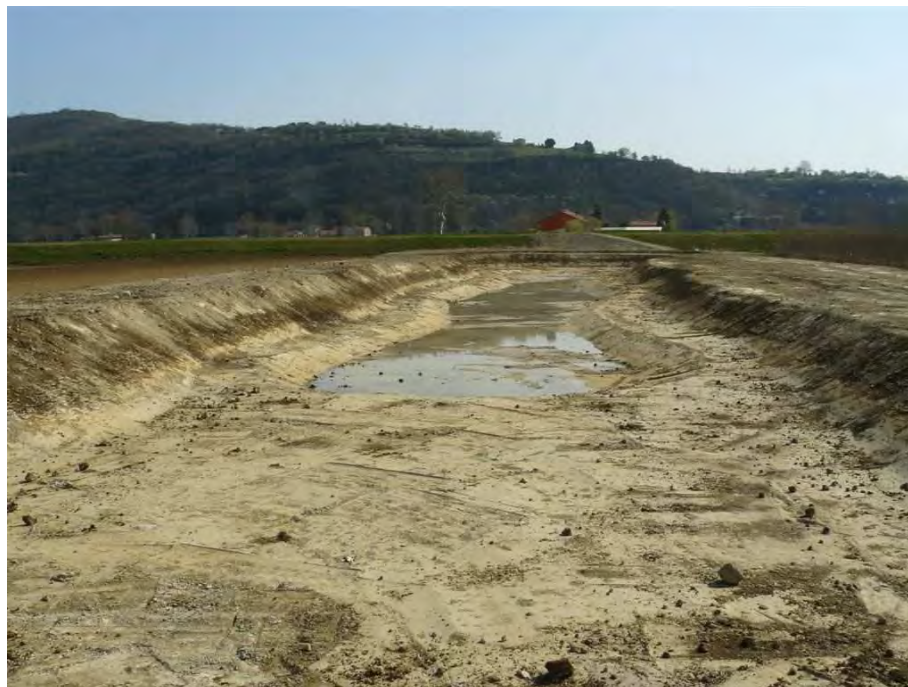
Figura 5-5. Fase di realizzazione del bacino
