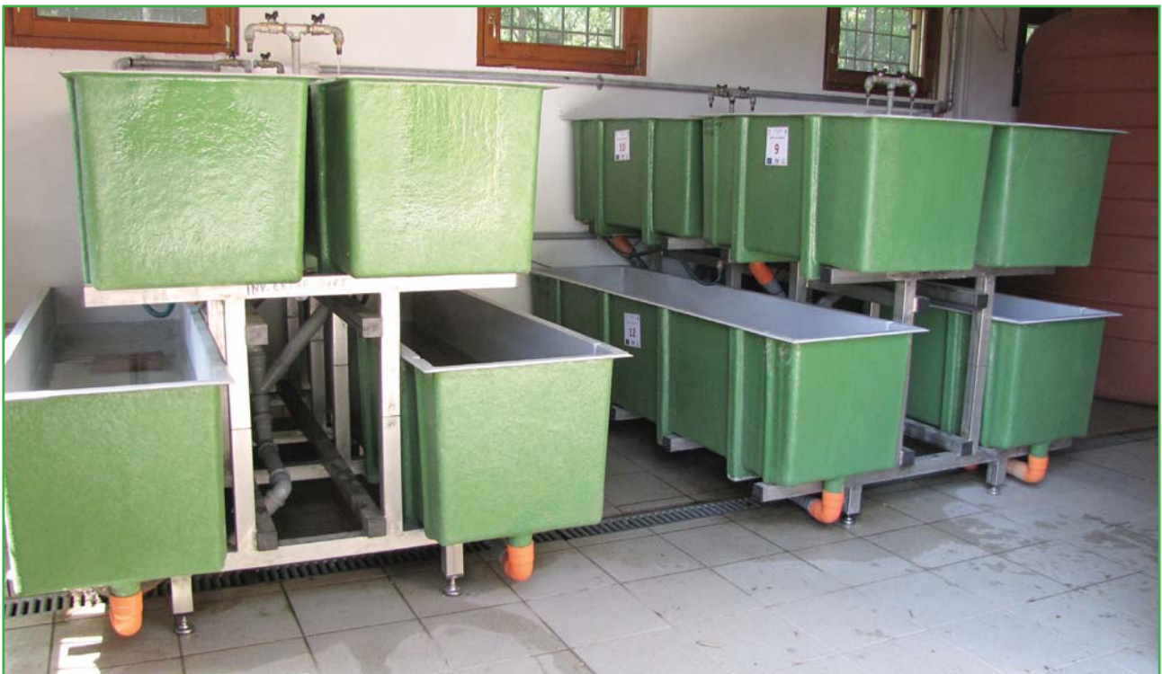
FIGURA 19. Vasche montate sul castello in acciaio.
