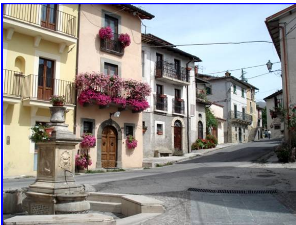
Il Borgo ristrutturato di Retrosi ad Amatrice (RI)
