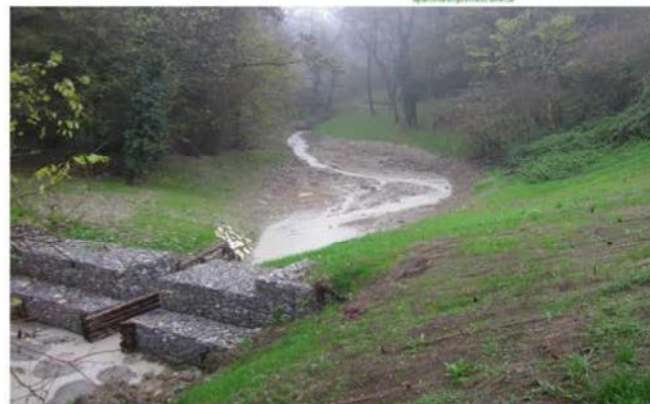
3 – Restringimento di sezione in pietrame a bocca tarata (10/11/2014)
