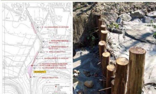
A sinistra: opere realizzate lungo il Rio Bianello. A destra: 1 – Briglia selettiva (10/03/2015)
