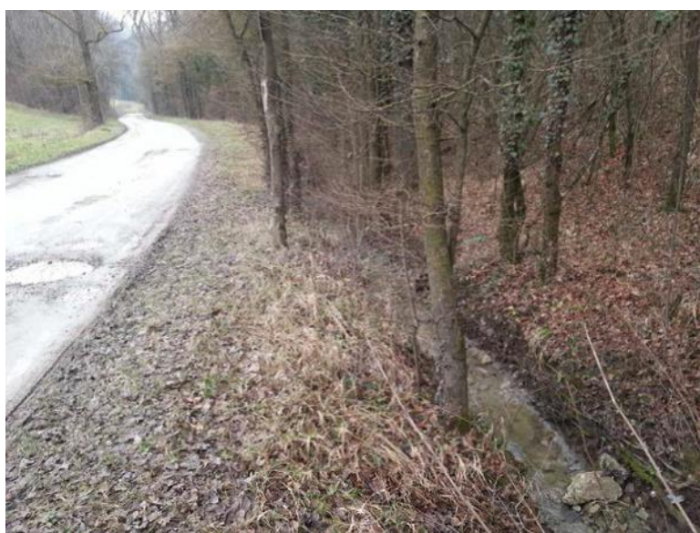
Figura 24 - Segmento 1 - Rio Enzola – Situazione pre-intervento
