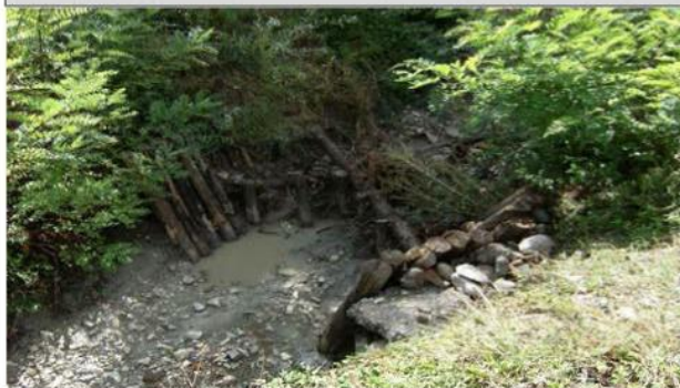
22 – Salto di fondo naturaliforme (trinci incrociati) (18/08/2015)
