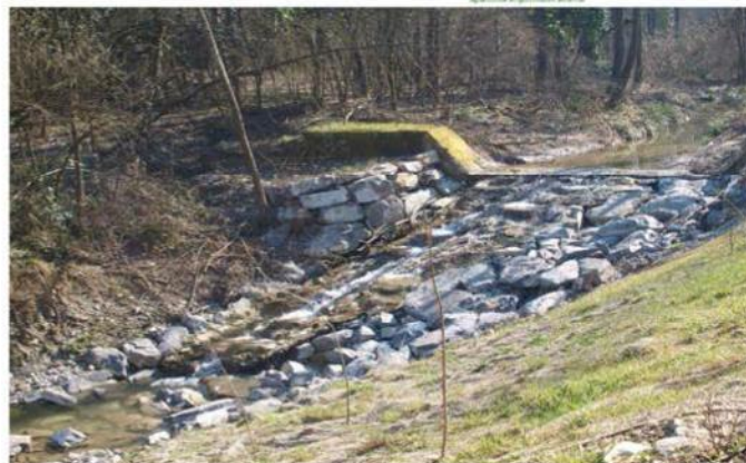
2 – Rampa in massi su briglia esistente(10/03/2015)
