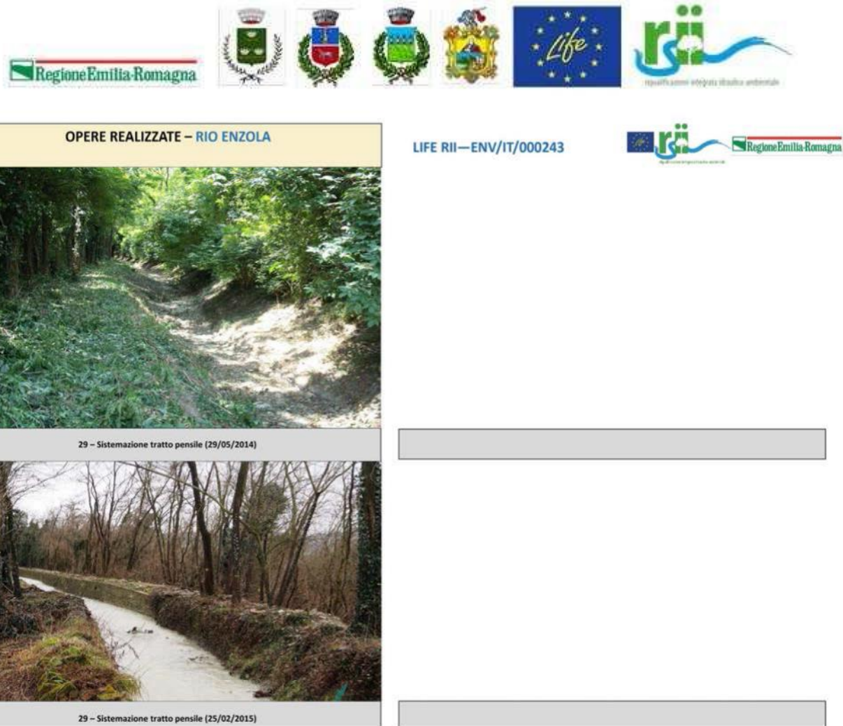
Figura 2 – Interventi realizzati lungo il Rio Enzola
