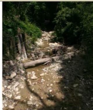
16-21 – Salto di fondo naturaliforme (trinci incrociati) (29/04/2016)
