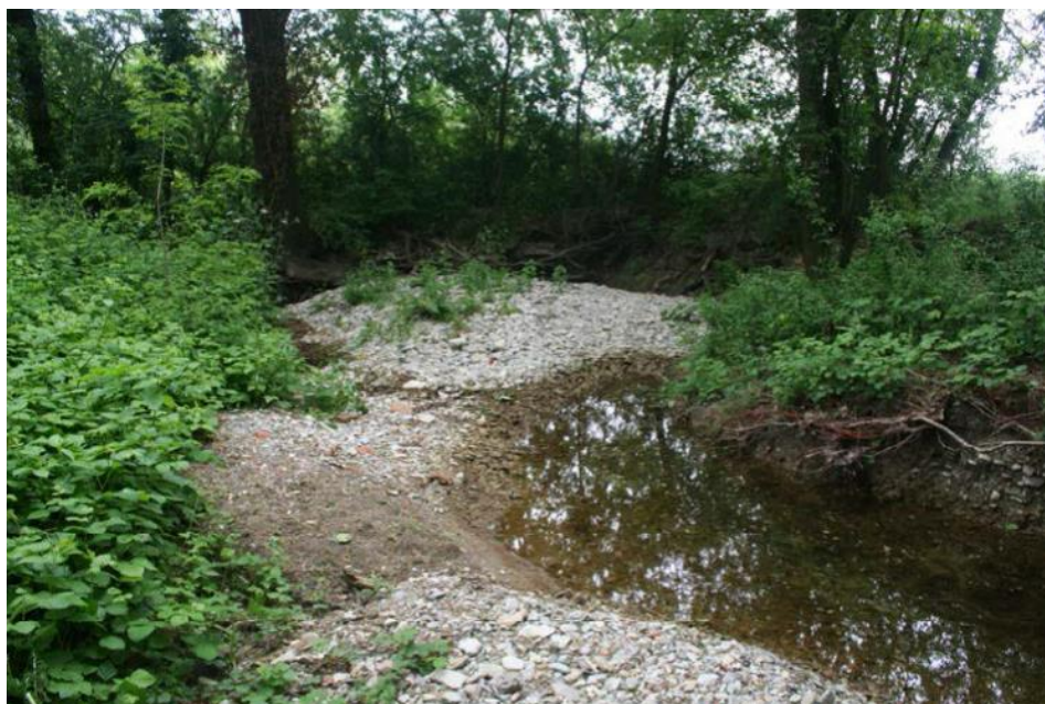
Figura 34 - Segmento 2 - Rio Lavezza – Situazione pre-intervento
