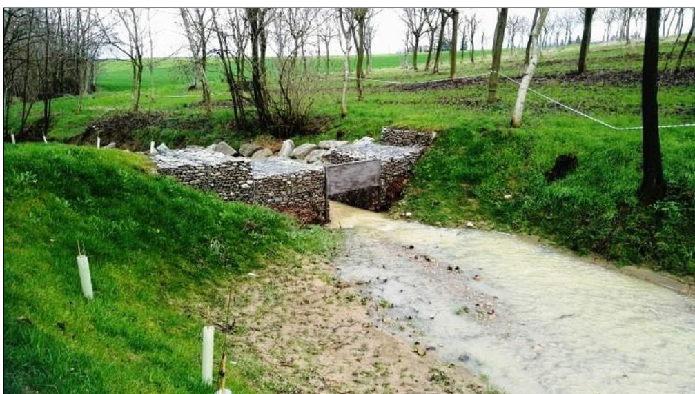
Figura 11 – Il restringimento in pietrame rinverdito realizzato sul Rio Montefalcone durante una piena nella primavera 2016.
