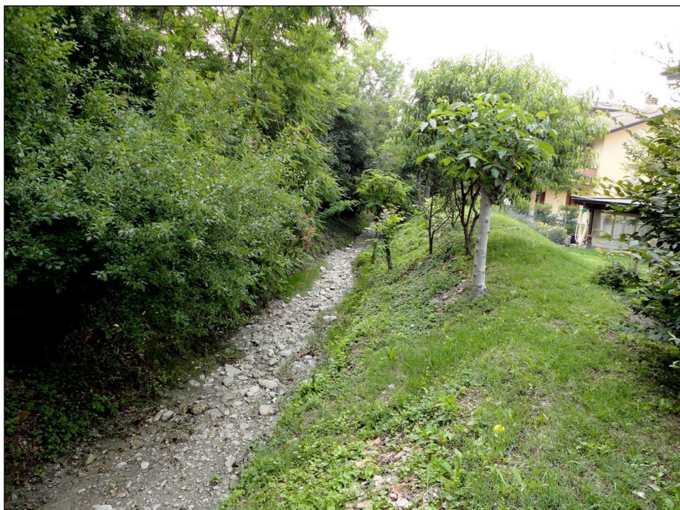
Figura 2 – Il tipico aspetto dei rii prima del progetto: si tratta di alvei stretti, incassati e dalle morfologie molto banalizzate, spesso privi di acqua per lunghi periodi dell'anno.
