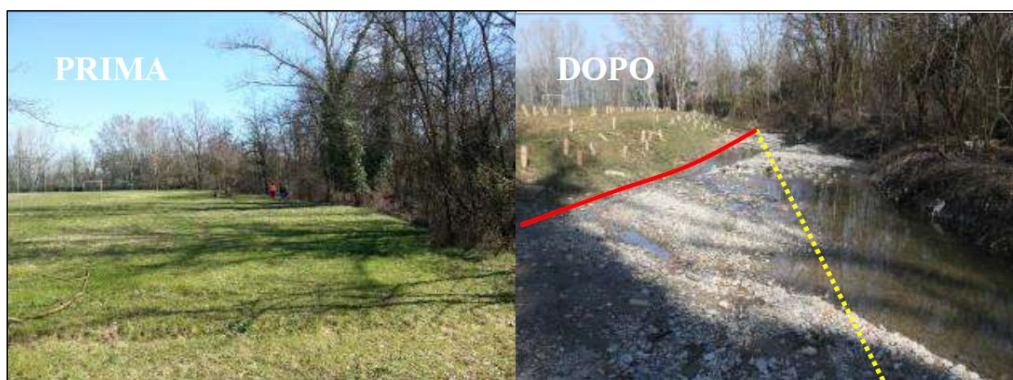
Figura 6 – Esempio di allargamento di sezione lungo il Rio Lavezza, realizzato in corrispondenza del campo sportivo di Albinea.
