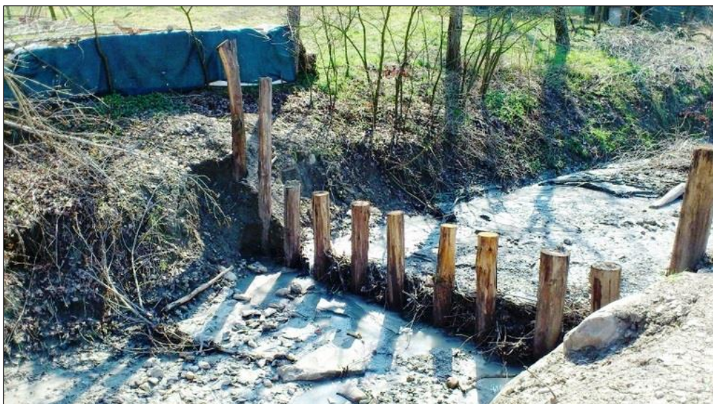
Figura 20 – La briglia selettiva sul Rio Bianello nella primavera 2015. Si nota un notevole accumulo di detriti a monte del filtro a pettine.
