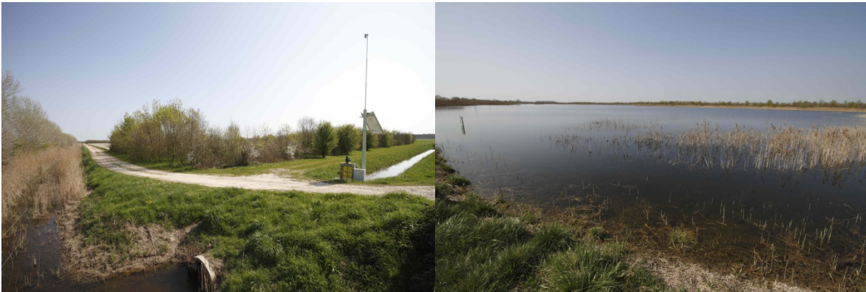
Fig. 2 – A sinistra il canale ed una vasca di fitodepurazione con la relativa cintura a siepe, a destra il bacino di accumulo circondato da una fascia a Phragmites australis .
