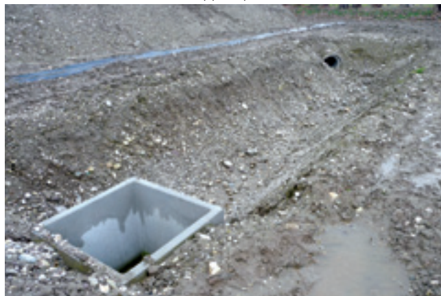
Foto 16 - Particolare della trappola per sedimenti in realizzazione
