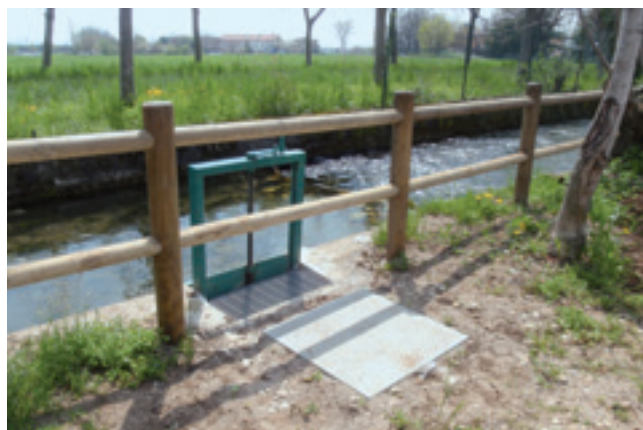
Foto 18 - Condotta di derivazione
