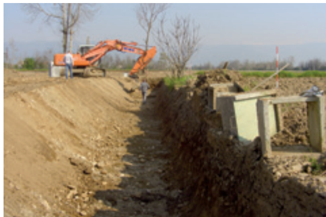
Foto 23 - Lavori di scavo per posa tubazioni sub-infiltrazione
