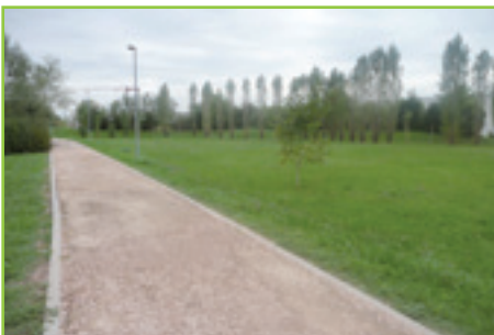
5. Breganze (VI): pozzi di infiltrazione
