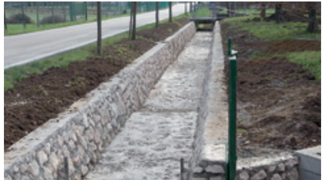
Foto 12 - Sistemazione delle sponde e del fondo della roggia
