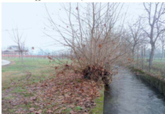
Foto 17 - Roggia Verlata e area prima dell'intervento
