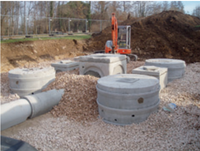
Foto 30 e 31 - Lavori in corso
