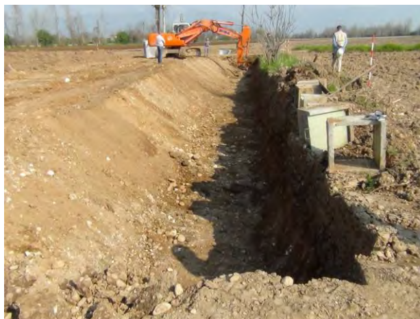
scavo trincea di posa
