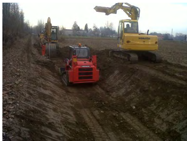
scavo a sezione aperta di progetto
