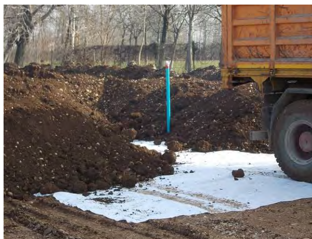
posa in opera geotessuto e rinterro superficiale
