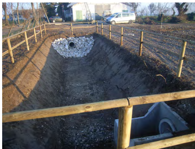
realizzazione trappola per sedimenti
