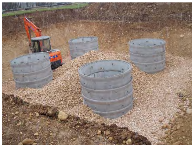
posa in opera anelli forati e riempimento con materiale inerte
