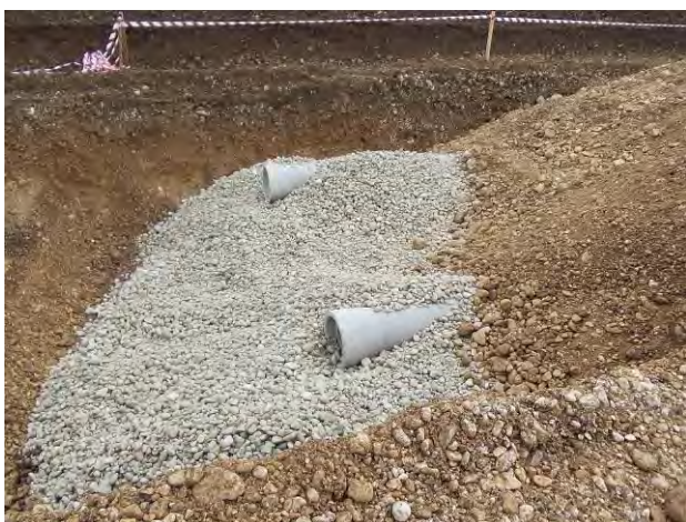
riempimento con inerte e posa in opera tubi disperdenti
