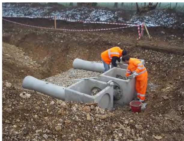
posa in opera di manufatti di alimentazione
