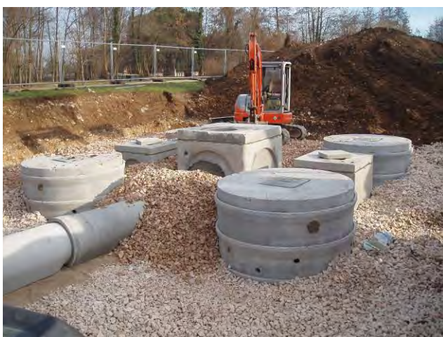
posa in opera tubi di adduzione e chiusura pozzi
