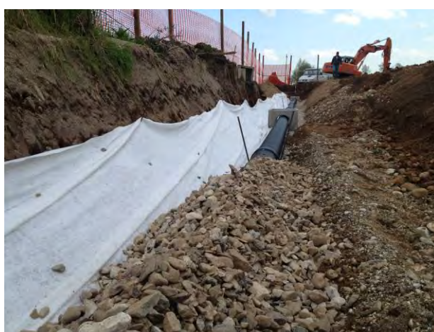
posa in opera geotessuto e rinterro superficiale
