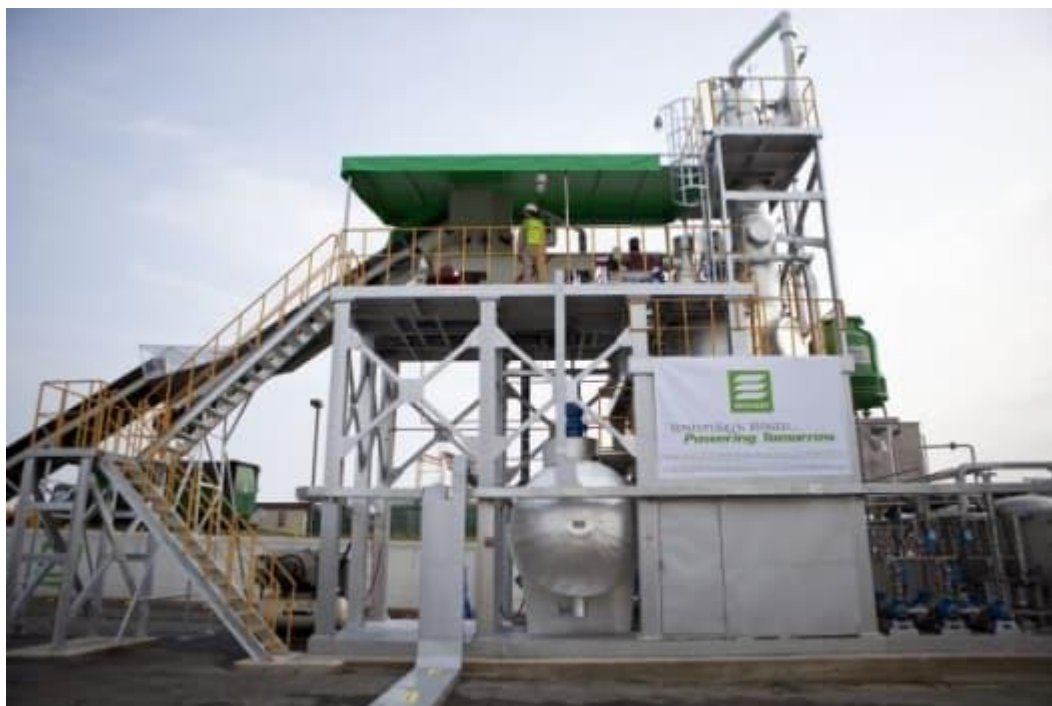
Figura 3-5 Impianto di pirolisi della Envion in Maryland – USA ( http://www.gizmag.com/envion-plastic-waste-to-oil-generator/12902/pictures )
