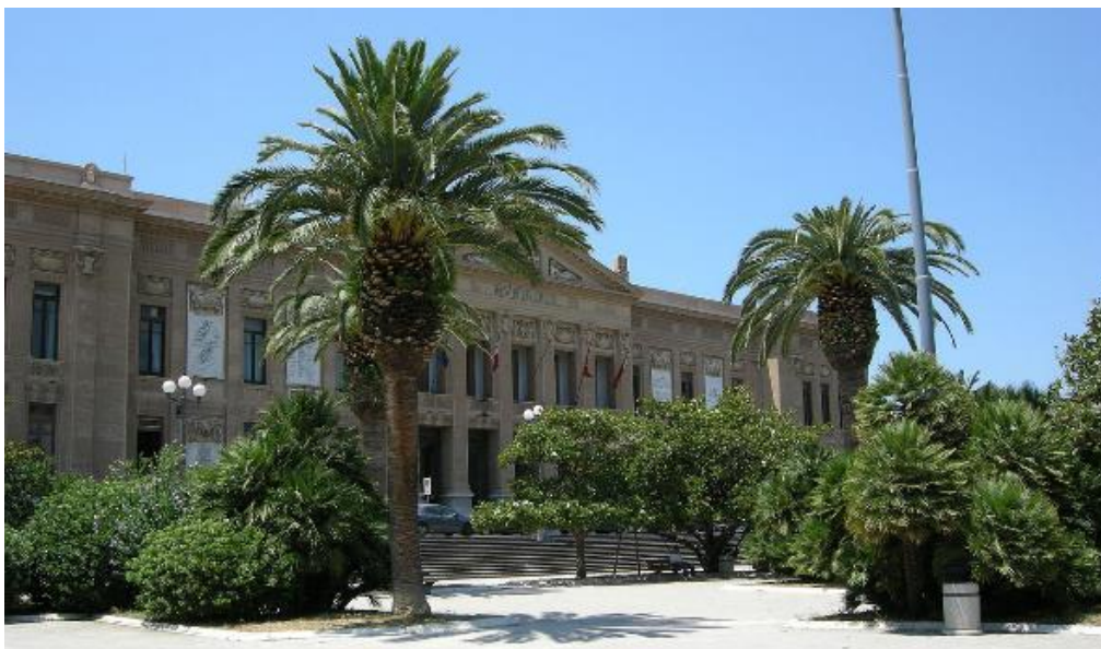
FIGURA 2 – VISTA ESTERNA DI PALAZZO ZANCA
