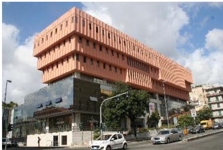
FIGURA 10- VISTA ESTERNA DEL PALAZZO DELLA CULTURA (PALACULTURA)
