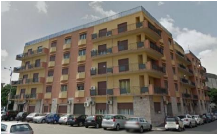
FIGURA 5 - VISTA ESTERNA DI PALAZZO SATELLITE
