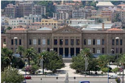
FIGURA 13 – EDIFICIO Zanca (Messina)
