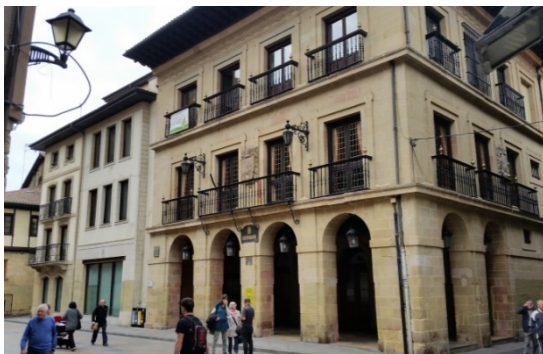
FIGURA 19 – Edificio di City Hall (Errenteria)
