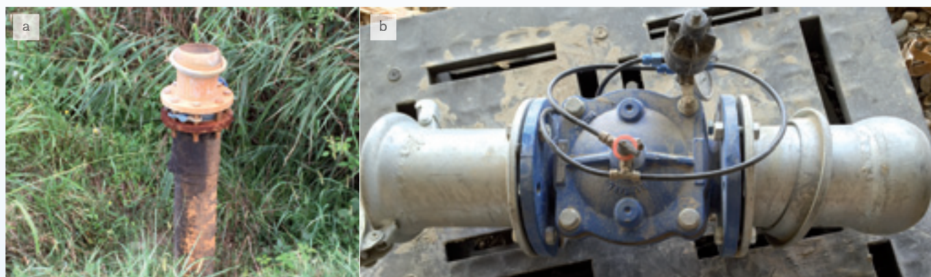
Foto 8. Sistema di derivazione (a) idrante in campo; (b) valvola di riduzione della pressione.
