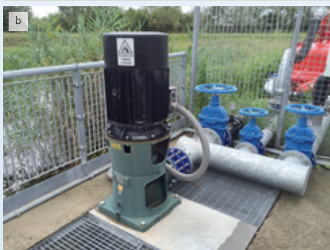
Foto 7. Bacino piccolo di raccolta dell'acqua: (a) vista complessiva; (b) pompa per l'irrigazione; (c) filtro.
