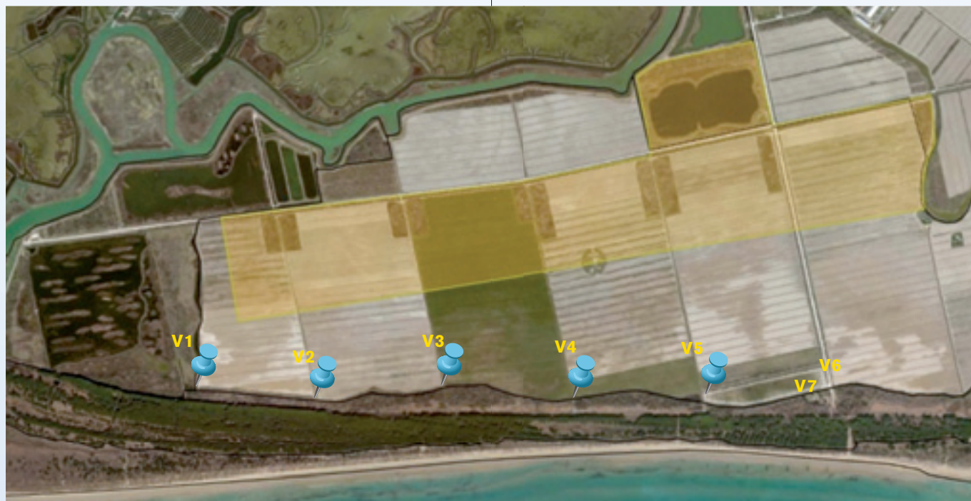
Figura 37. Stazioni di monitoraggio della salinità sul canale Vallo Corò (V1-V7).
