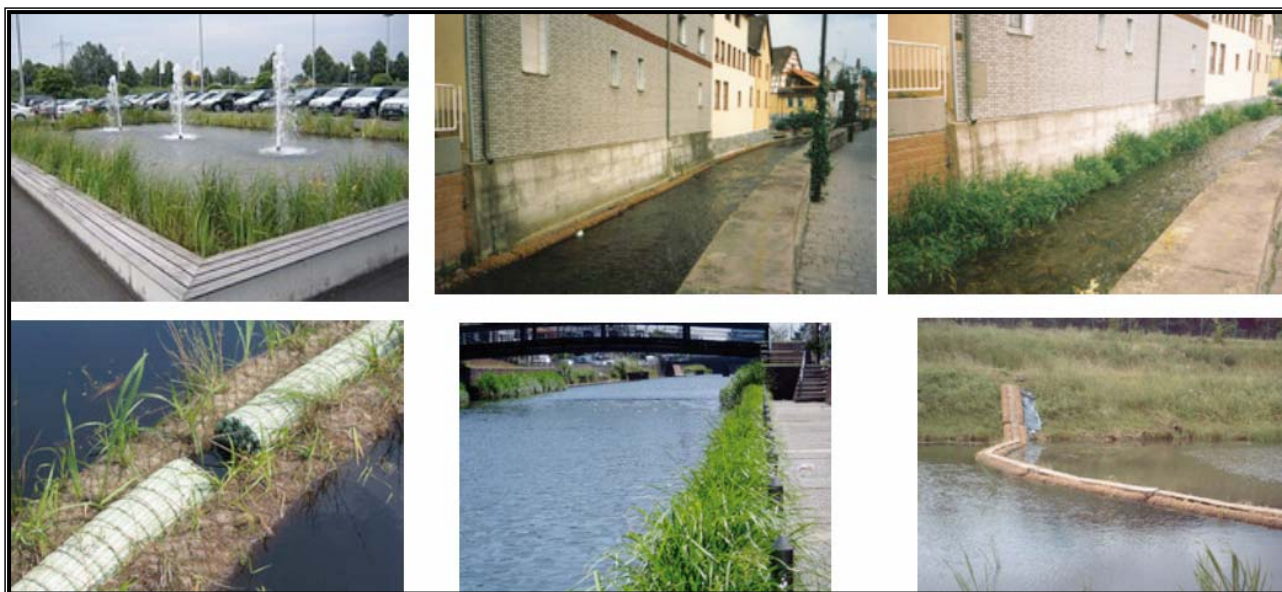
Figura 27 - Barriere galleggianti (ACQUAGREEN®) realizzate con rulli vegetati
