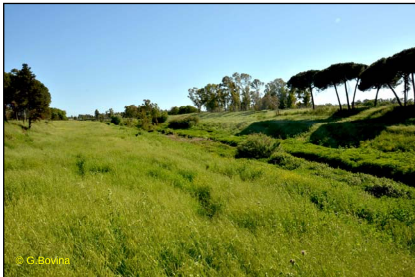
Figura 15 – Sistema arginale del Canale Acque Alte con argine superiore in elevazione dal piano campagna
