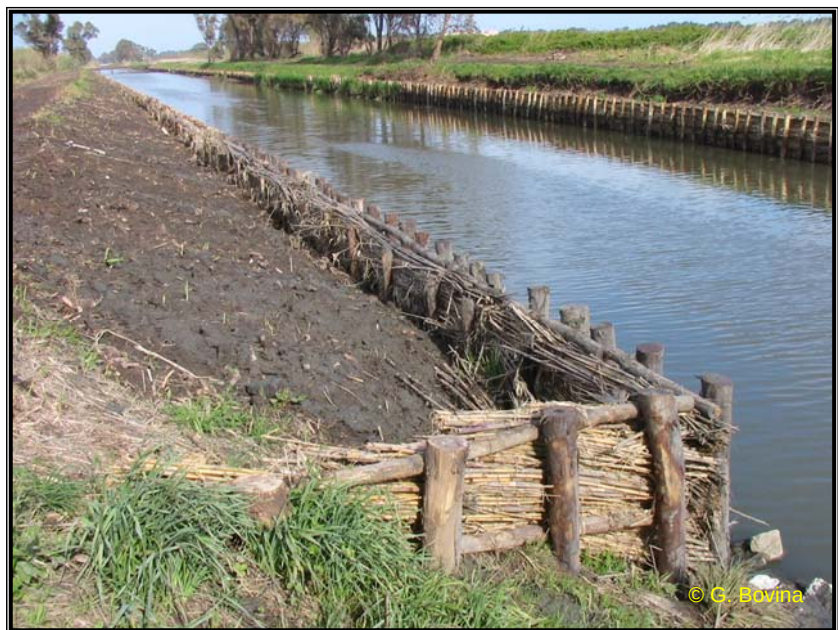
Figura 44 – protezione spondale del canale Colmata, Lido di Latina
