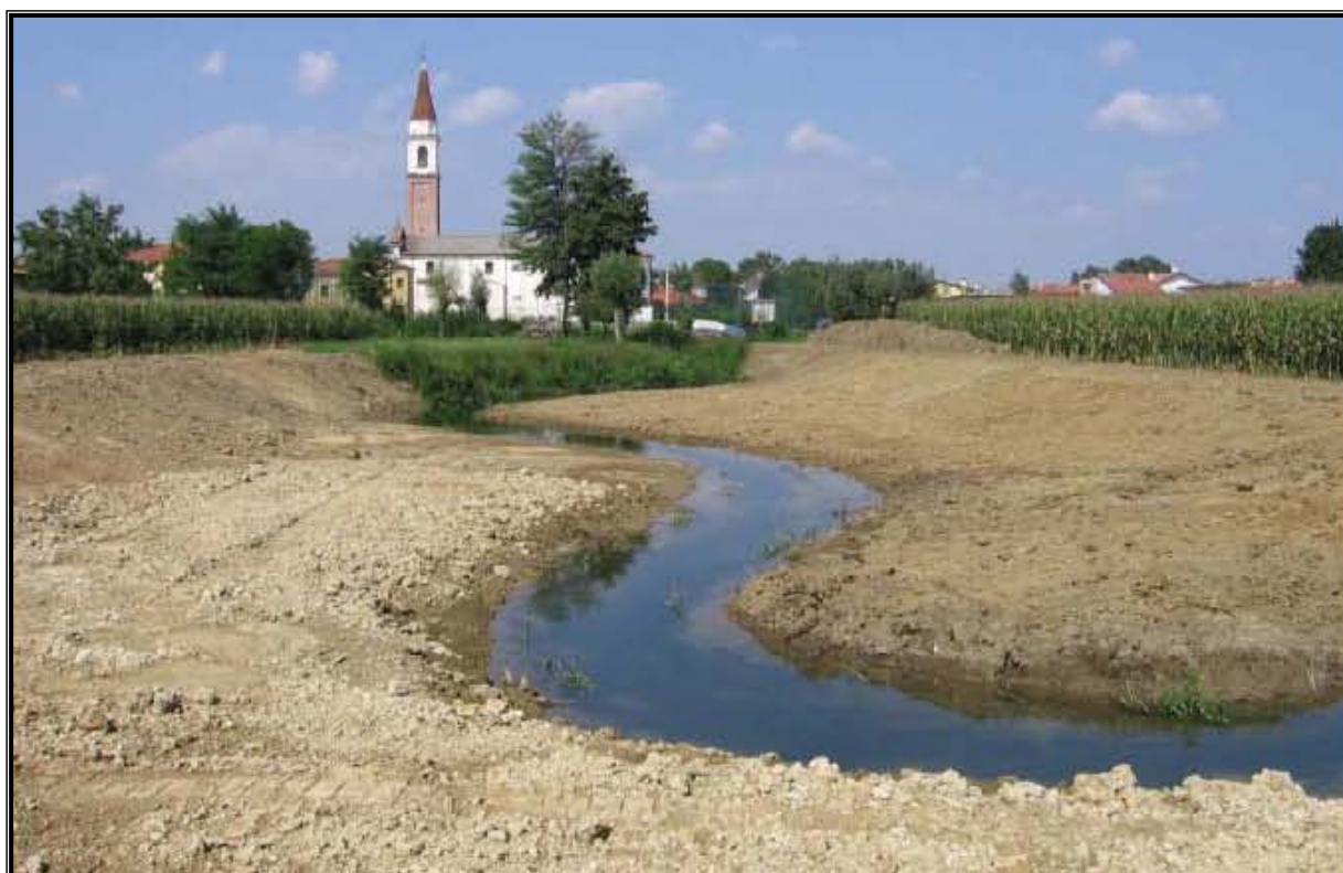
Figura 7 – ricalibratura dell'alveo con andamento sinuoso del canale di corrente e realizzazione di banchine di espansione a pendenza variabile (da "Riqualificazione fluviale" Rivista del CIRF n. 4/11)
