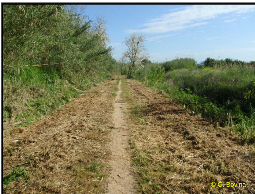
Figura 58 - esiti della trinciatura della vegetazione lungo la pista di servizio del canale Mastropietro
