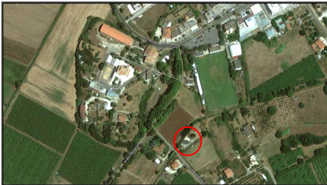
Figura 8 - Depuratore Bella Farnia
