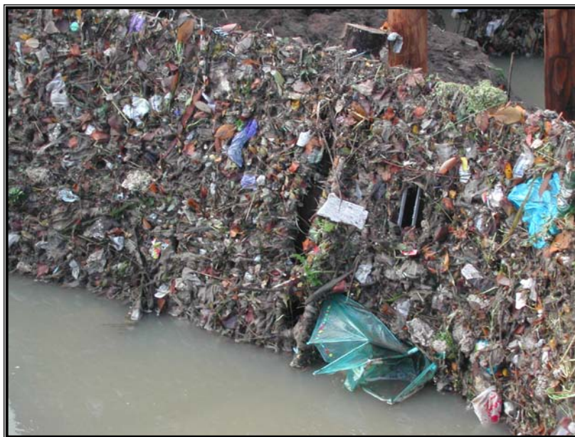
Figura 42 - Rifiuti solidi e detriti vegetali trattenuti da un sistema di sgrigliatura sul Fosso Paoloni (Latina - Quartiere Nascosa)
