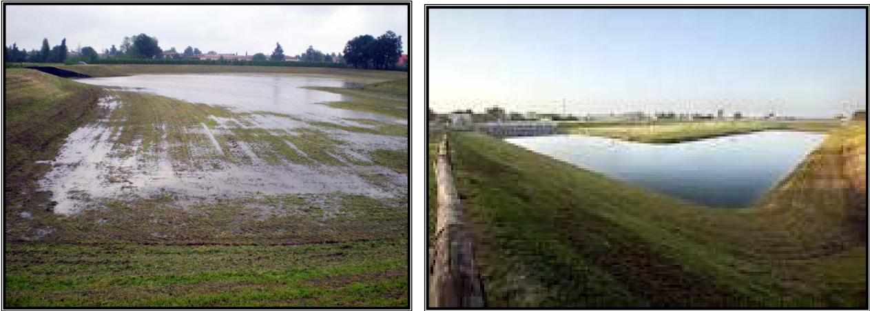
Figura 32 – esempi di casse d'espansione
