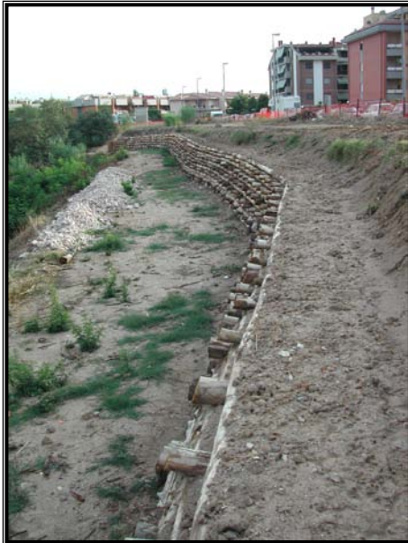
Figure 66,67,68 – interventi di difesa spondale
