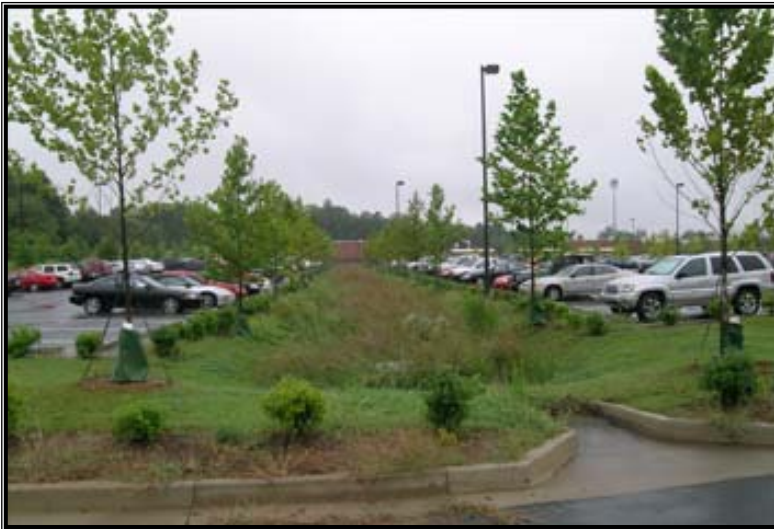
Figura 19 - Fosso di infiltrazione (Da: Verri G. 2011)
