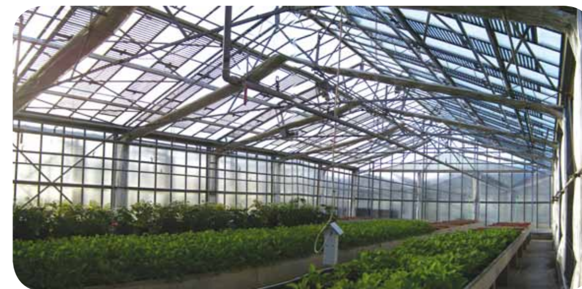
Figura 6. Pannelli CIS (Diseleniuro di rame e indio) semitrasparenti installati all'interno delle falde di una serra sperimentale presso il Cersaa di Albenga.
