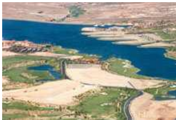
Figura 10 Stagni di trattamento terziario
