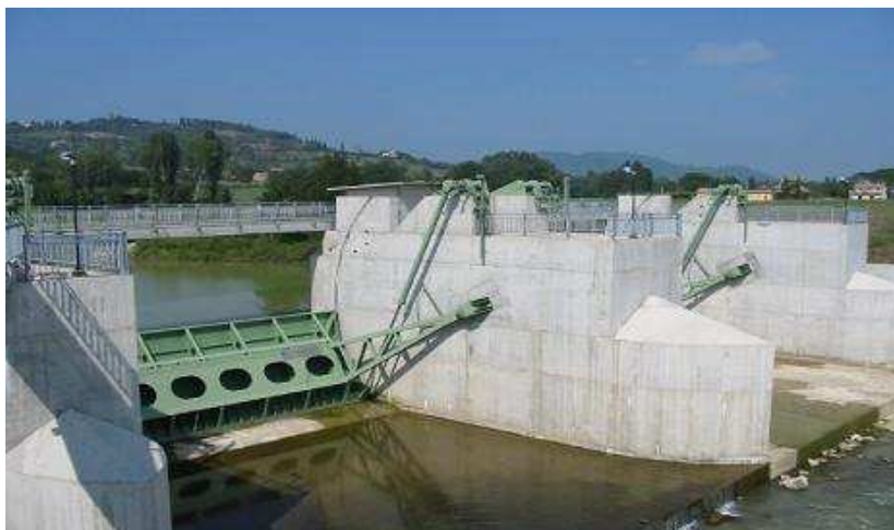
Fig. 6.4 – Centrale idroelettrica di Umbertide, località Mola-Casanova
