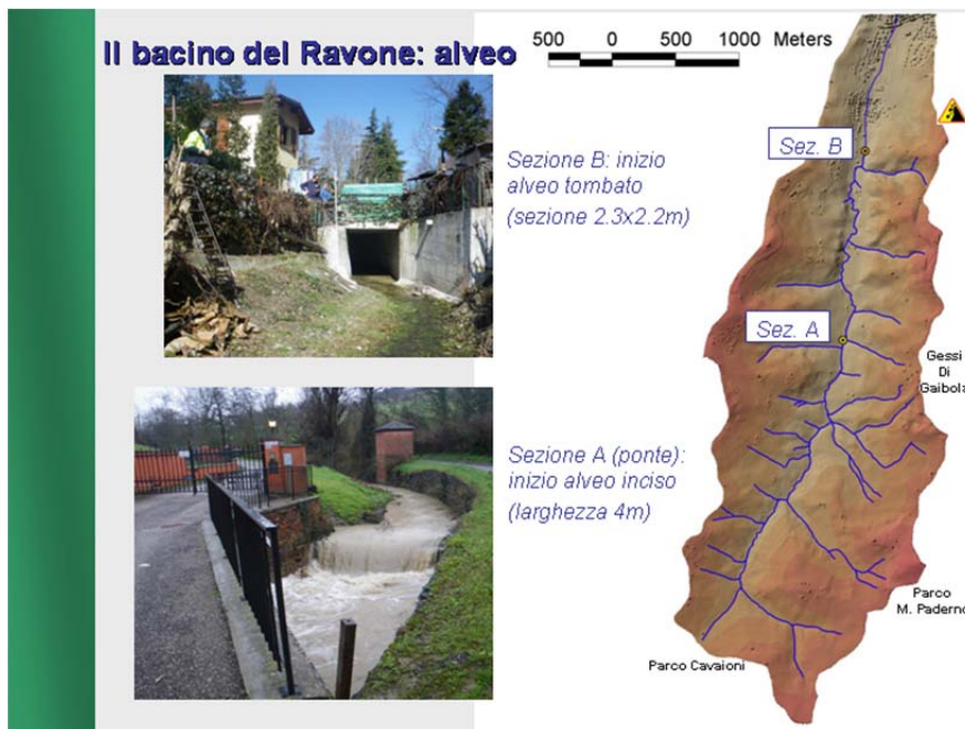
Fig. 28. Alveo del torrente e due sezioni vulnerabili
