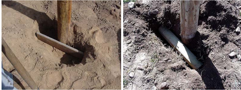
MESSA IN POSA DI UN PALO CON SUPPORTI A T ROVESCIAIA
