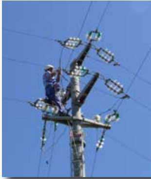
Messa in sicurezza linee.
