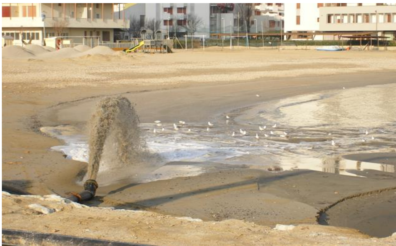
Figura 6: Intervento di ripascimento di un tratto di spiaggia emersa.
