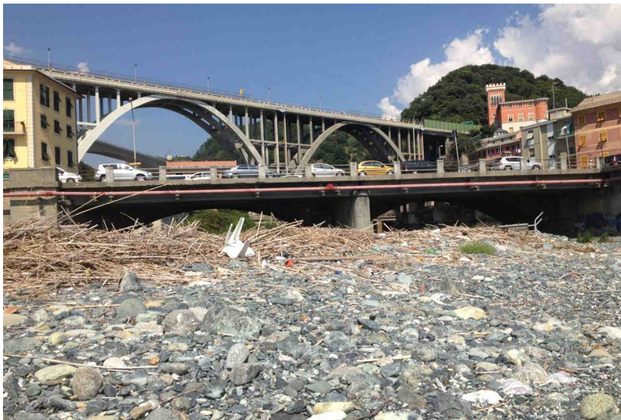
Figura 4 – Copertura alla foce - Torrente Cerusa
