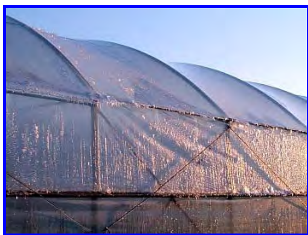
Fig. 31, 32. S2 (a sinistra) : formazione del ghiaccio sulle pareti laterali, S1 ( a destra) assenza di ghiaccio sulle pareti laterali perché l'acqua è captata dalla grondaia.
