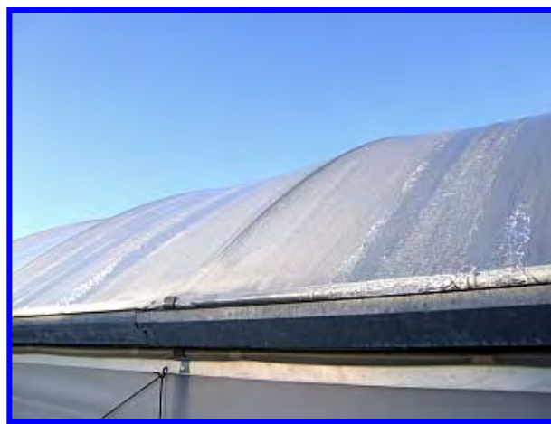
Fig. 31, 32. S2 (a sinistra) : formazione del ghiaccio sulle pareti laterali, S1 ( a destra) assenza di ghiaccio sulle pareti laterali perché l'acqua è captata dalla grondaia.
