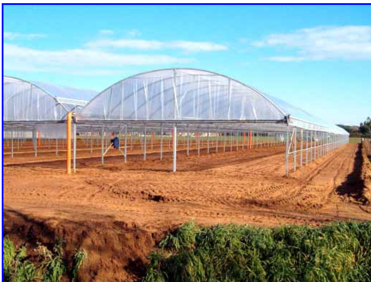
Le serre attualmente costruite con intelaiatura in ferro zincato, grondaie e sistemi di apertura laterale e in testata.
