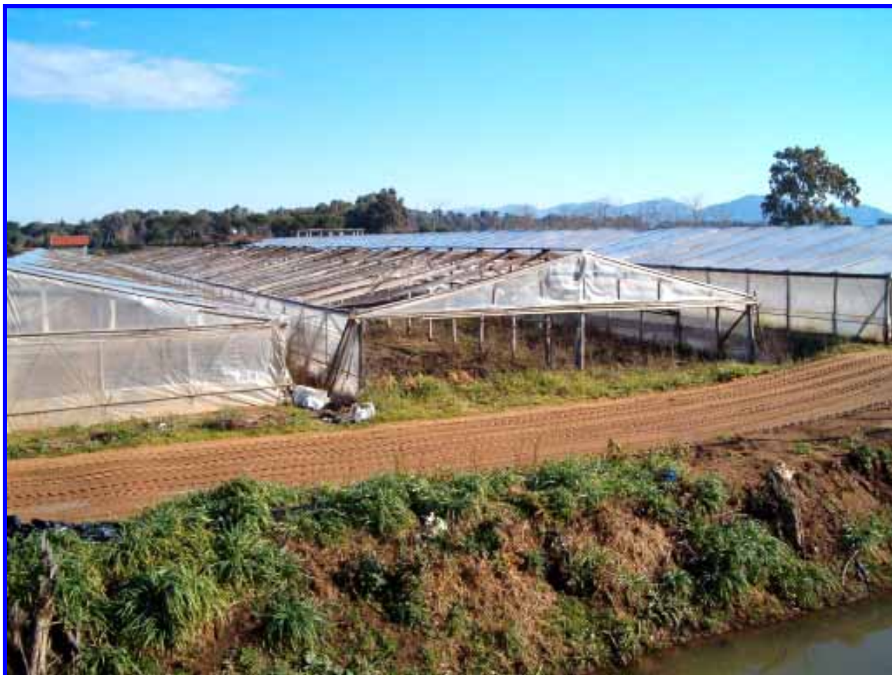
Le prime serre costruite agli inizi degli anni 70 con intelaiatura in legno
