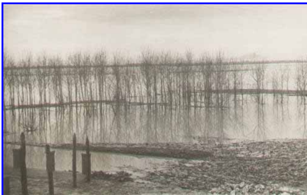
Le sponde lacustri in un'immagine degli anni '50 che testimonia i frequenti fenomeni di sversamento antecedenti alla costruzione delle arginature
