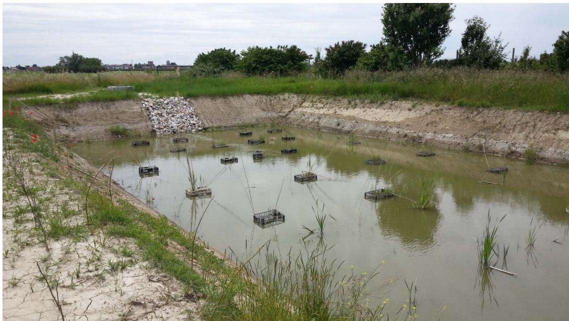
Particolare dell'impianto di fitodepurazione.
